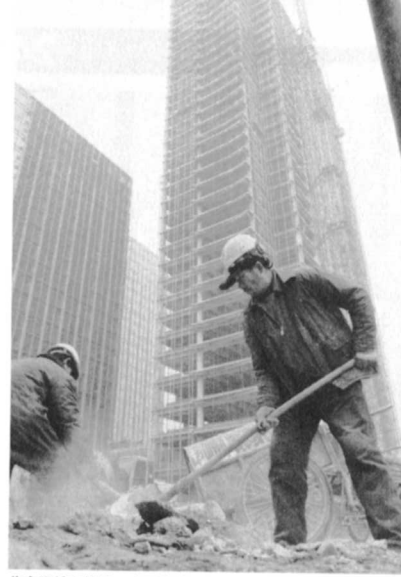
北京五輪を控え、中国各地で目にするビルの建設工事
